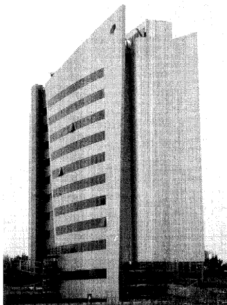
L'albergo, in fase di finitura, che sorge all'uscita dell'autostrada
